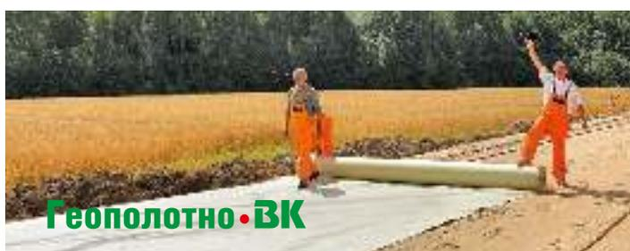
**Геополотно нетканое иглопробивное марок ВК, ВКт, ВКтж, ВКб, СТО 21506643.001-2015** - это водопроницаемый нетканый материал, полученный путем скрепления сформированного волокнистого холста из штапельных синтетических волокон иглопрокальванием. Кроме того, полотно проходит термическую обработку (нагрев) с целью улучшения его потребительских свойств.
